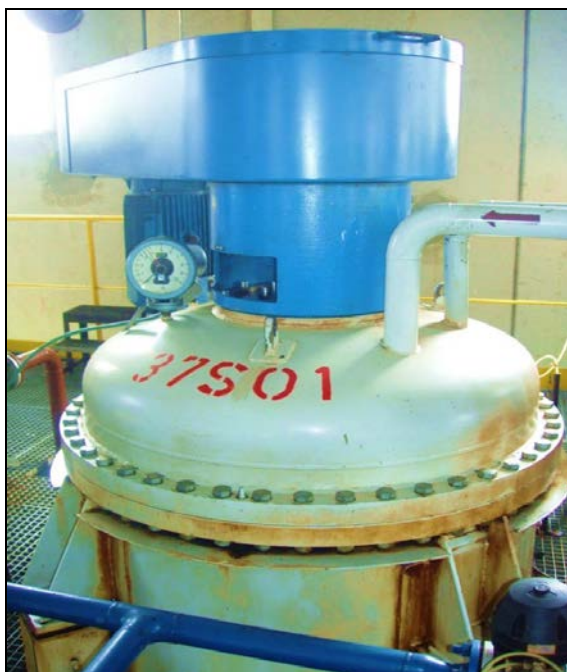
Slika 4. FUNDA filter koji se koristi na postrojenju Bijeljenja baznih ulja a) gornji dio filtera sa centralnom osovinom b) kućište filtera
